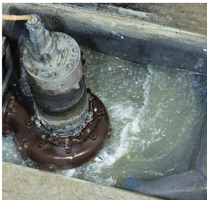
Насос для загрязненной воды с двигателем с собственным охлаждением
